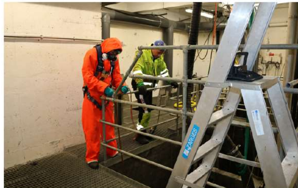
Bilde 3 Arbeid i og ved åpne bassenger, avløp (Foto: IVAR IKS)
